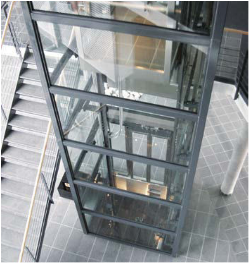
Trubková konstrukce šachty, čtvercové jeklové profily Zasklení mezi profily
