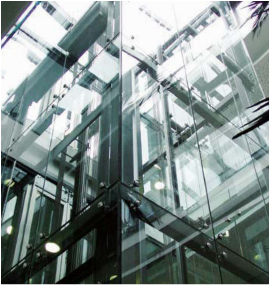
Trubková konstrukce šachty, čtvercové jeklové profily Upevnění skla – bodové zasklení, Zasklení před profily
