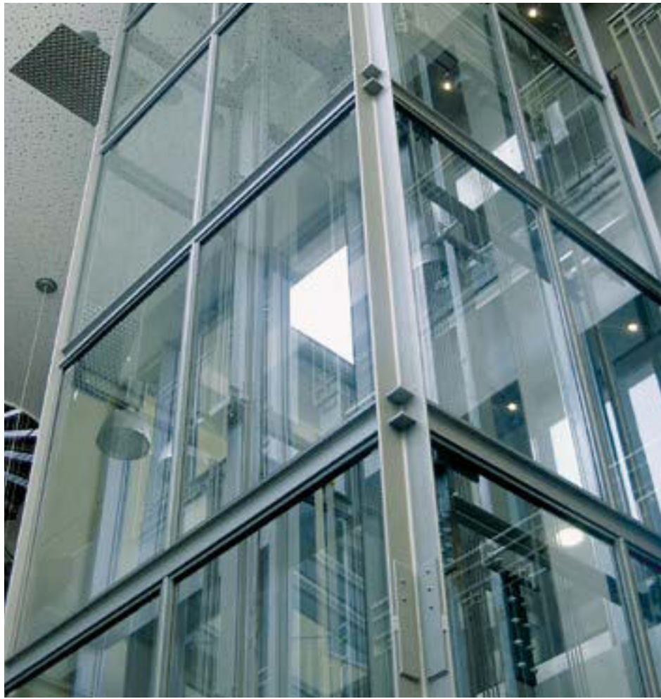
Úhelníková konstrukce šachty Úhel otevřen ven
