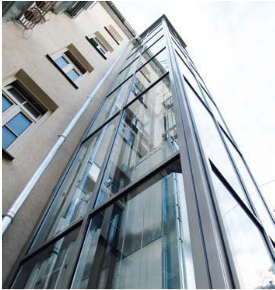
Trubková konstrukce šachty, čtvercové jeklové profily Hliníkový fasádní profil
